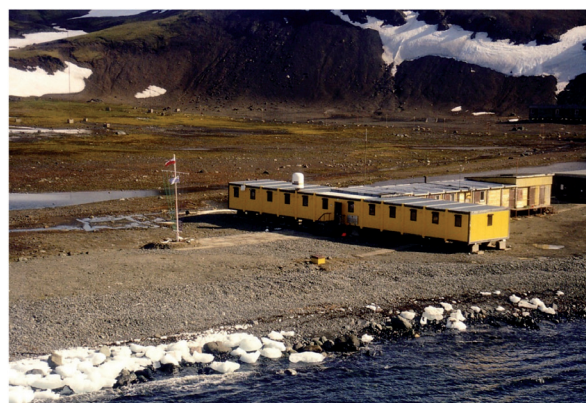
Ryc. 4. Główny budynek stacji Henryka Arctowskiego na wyspie King Georg (Szetlandy Południowe).
