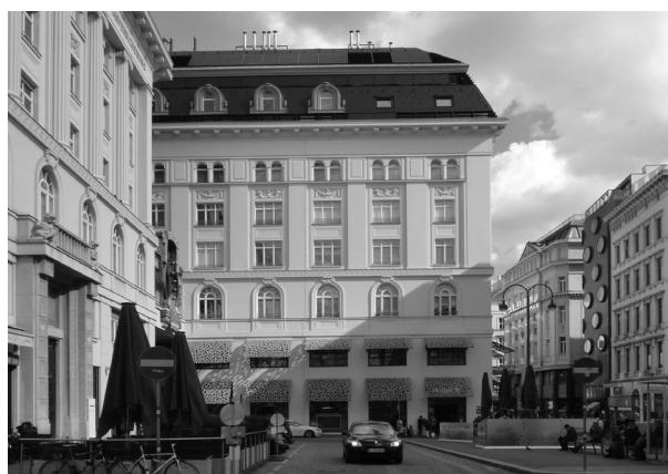
Ryc. 33. Merkur — markizy z rastrem wykonane w firmowym kolorze, Hoher Markt, Wiedeń 2015 r. (fot. Joanna Suchowiak).
